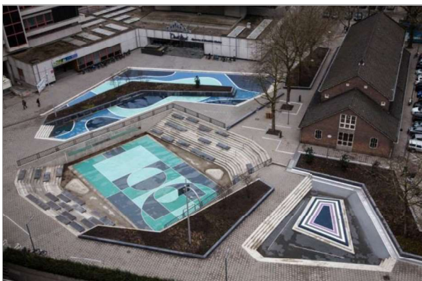
3 pav. Benthemplein water skvere sausasis baseinas sausuoju periodu naudojamas kaip rekreacinė erdvė – krepšinio ir žaidimų aikštelė (Rainwater Park, 2015)
