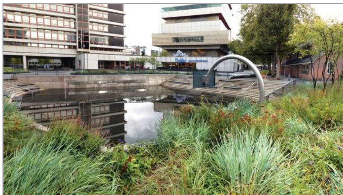
4 pav. Lietinguoju periodu baseinas užsipildo lietaus vandeniu, kuris palaipsniui išleidžiamas į kitas sistemas, dalis jo išgaruoja (Rainwater Park, 2015)
